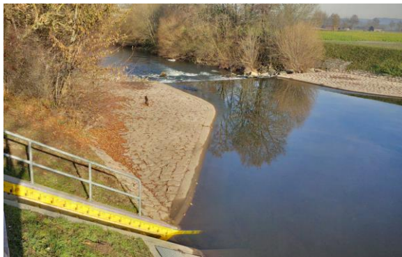
Zustand vor dem Umbau
