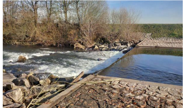
Zustand vor dem Umbau
